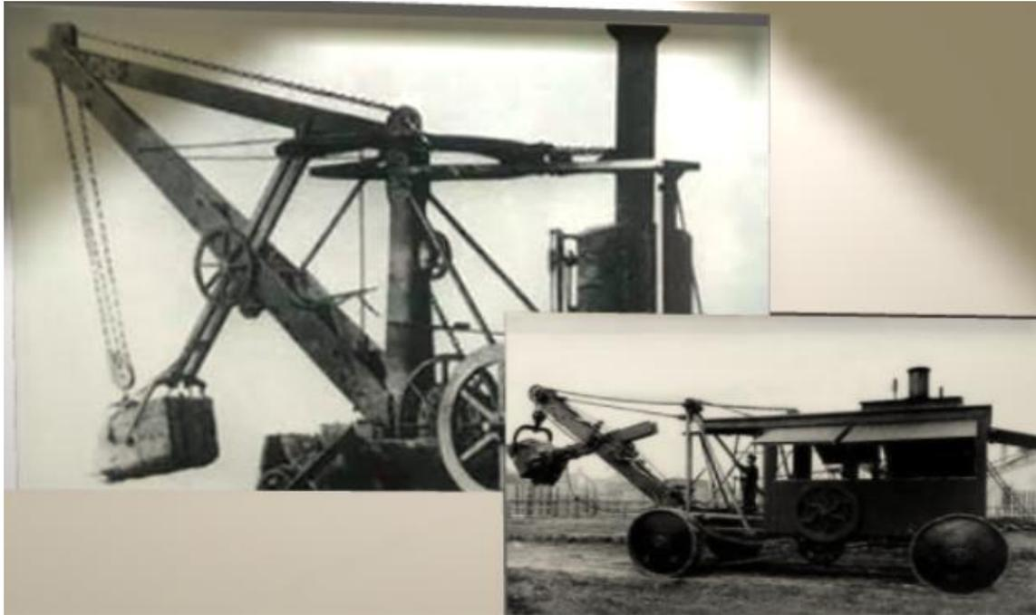
**简介：**挖掘机的发展历程已长达 178 年，从诞生之初，历经人力、蒸汽动力，逐步演进至液压驱动。作为工程机械领域的璀璨“明珠”，挖掘机的发明与持续发展，在节省人力、提升工作效率方面成效显著。最初的挖掘机以人力或畜力为动力，多为用于挖深河底的浚泥船，其铲斗容量通常不超 0.2 - 0.3 立方米。19 世纪 70 年代，改良后的蒸汽铲正式投入生产，并应用于露天矿剥离作业。
